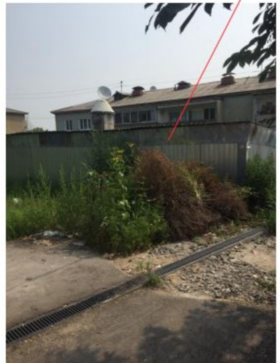
Фото с натуры с юго-западной стороны
