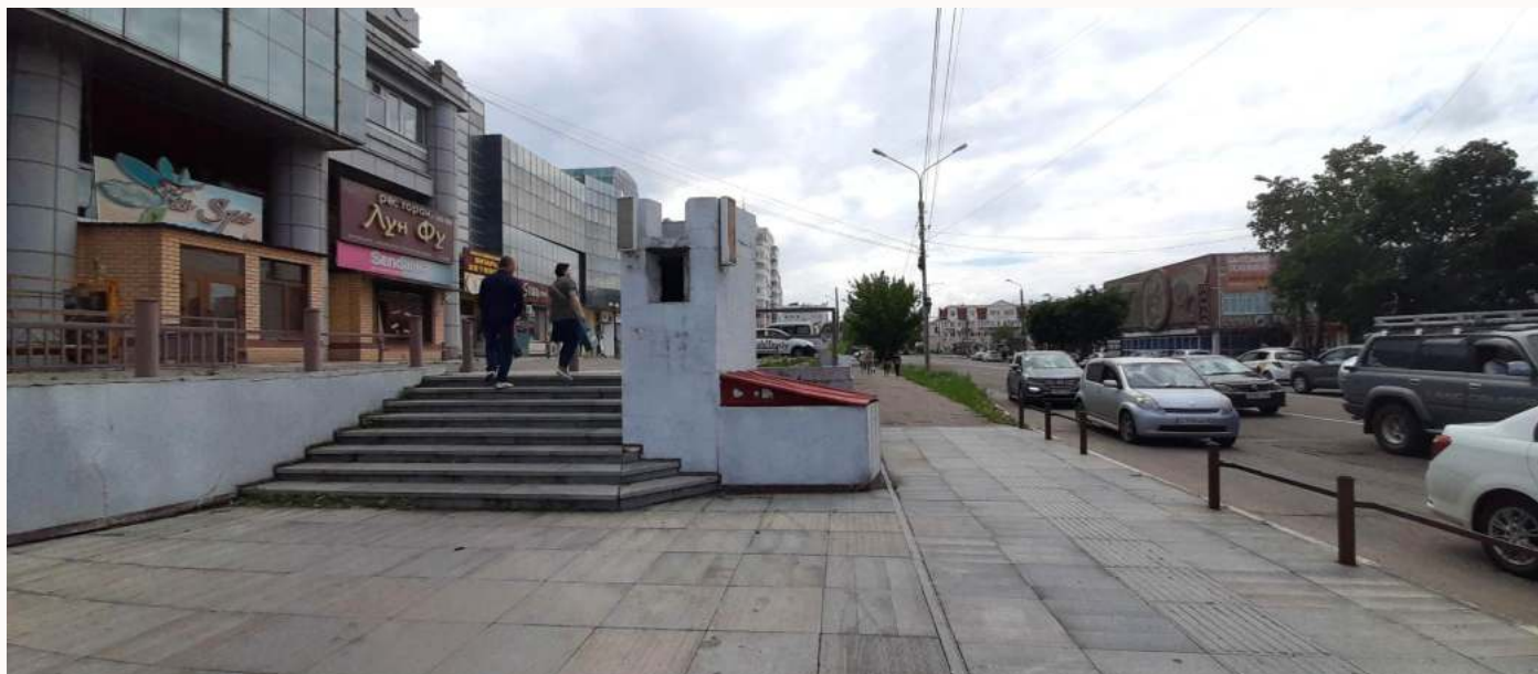
Основной пешеходный транзит, подпорная стенка возле гостиницы “Азия”
