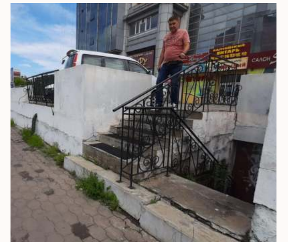
3. Ненормативная высота ступеней лестницы
