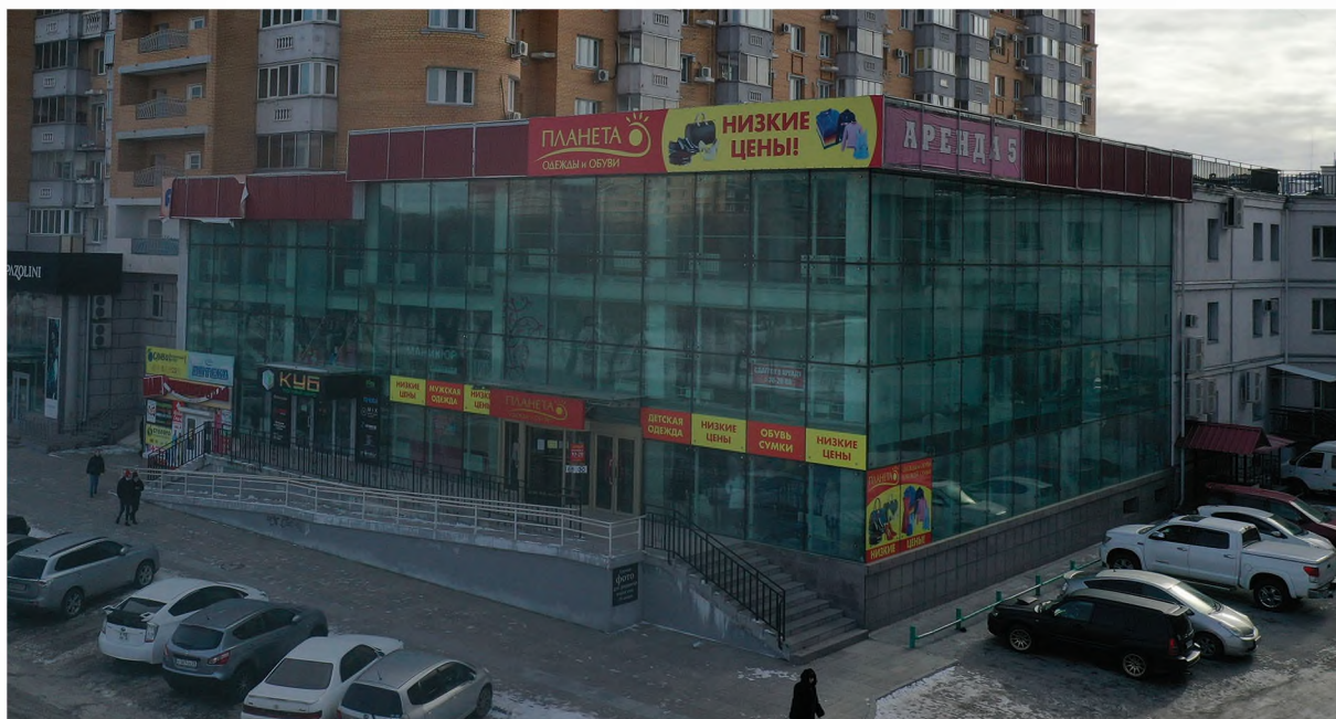
Общий вид на здание
